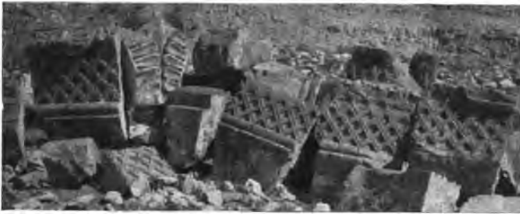
Abb. 159: Swartnotz, Kirchenruine: Reste des Kranzgesimses.
